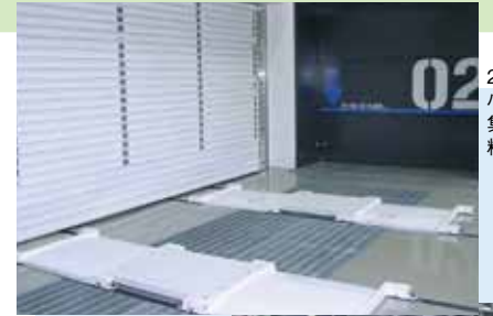
2階に移動した車両は パレットに乗せ、エアブローと 集塵装置により徹底的に 粉塵を排除
