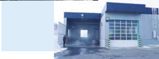
大型車、農機の洗車作業に専用棟を完備
