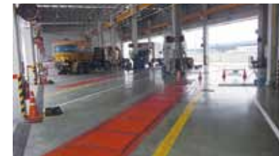
5スツール移動できる 天井クレーンも設備
