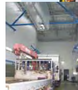
洗車場壁面の下部には ステンレス板を張り、 汚れ防止・美化と使い勝手に配慮。
