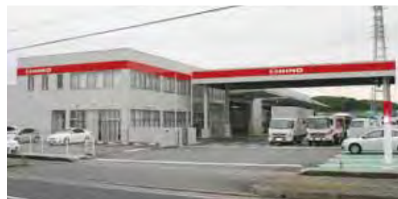
国道に面して大きな屋根を張り出したエントランス。
