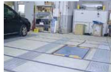
レール間にハーケスリフト3基を埋設設置
