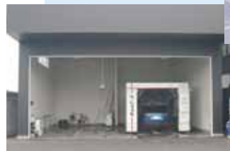
洗車棟は手洗い洗車ストールと門型洗車機を設備
