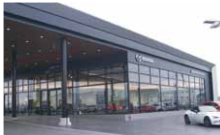
ショールームからエントランスへ大きなキャンビーが張り出す
