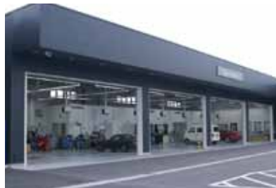
サービスストール外観、照明は全てLEDを採用
