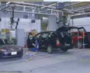
下地ストールには横移動レールと床面吸塵ダンパーを設備
