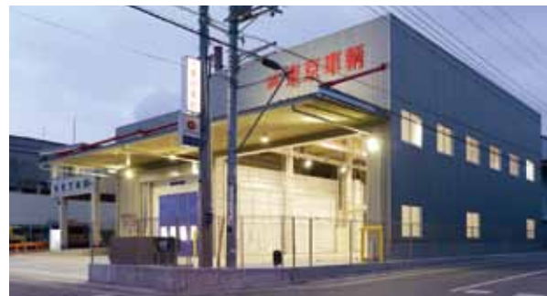
LED照明で夜も明るい工場に。建屋高さは11m。
