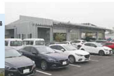
敷地奥のBPサービス工場
