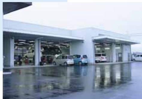
サービス工場外観。オーバースライダーシャッターを採用
