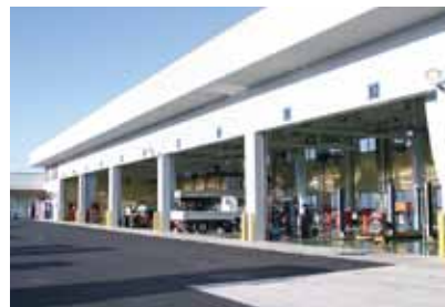
南向きとして明るいサービス工場、照明はLEDを採用
