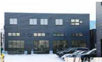
グレーを基調とした サービス工場の外観
