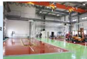
(左)大型専用ストール、走行クレーンのため柱と架台のない広い空間を実現
