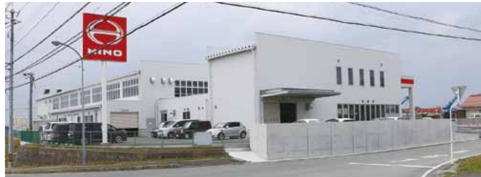
物流団地に建設された石見支店・サービス工場
