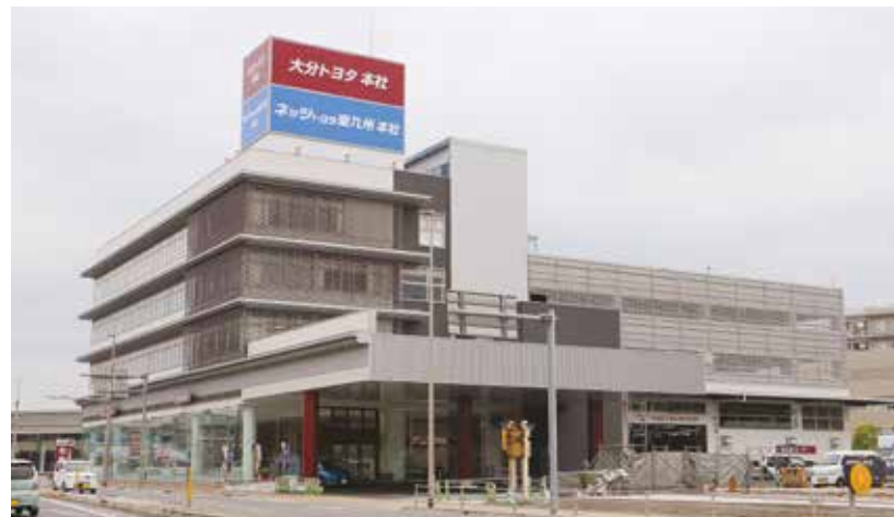
国道に面した本店ショールーム、2~5階が本社屋
