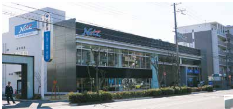
尼崎市から西方面の芦屋市へ向かう「山手幹線」に面した「ネットテラス夙川」
