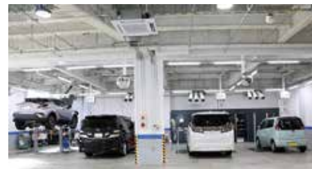
フラットキット付 タンデムリフトで 作業性の良い 空間に
