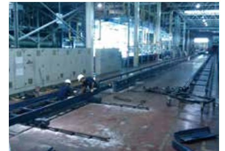
コンベアラインの設置工事
