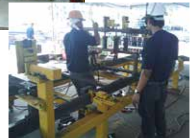
設備機器の修正、調整作業
