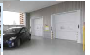
カーエレベーター2基で1階から屋上駐車場まで移動が可能。
