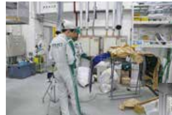
すべてのストールにエアコンダクトを設備。
