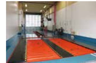
検査ライン。フリーローラー6基を接続し、あらゆる車両に対応
