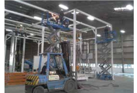
各種設備機器の設置、組立など幅広い業務を提供
