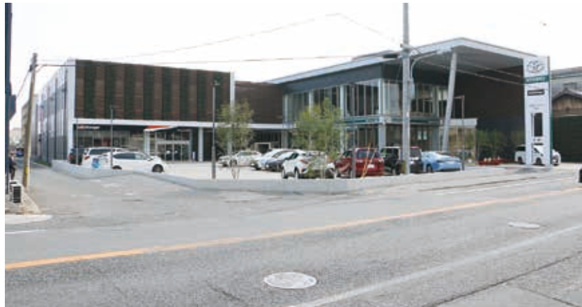
国道に面した廿日市店の外観。2つの店舗とサービス工場を併設
