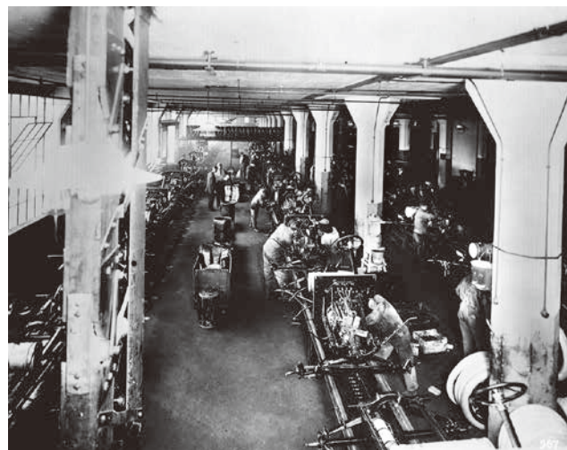
大量生産技術の確立・進化により自動車の普及とアフターサービス網の構築に大きく貢献したフォード・モデルT(1908年式)と、同車を生産する1914年当時のハイランドパーク工場(右)
