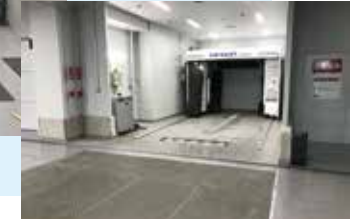
6本ブラシのエミネントレボリューションと下部洗浄機を設備。ストールの前にFRPグレーチングを敷設し水の飛散を防止
