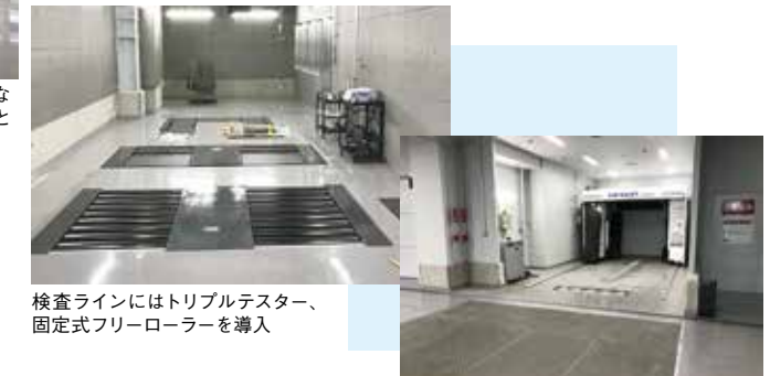
6本ブラシのエミネントレボリューションと下部洗浄機を設備。ストールの前にFRPグレーチングを敷設し水の飛散を防止
