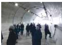
トンネル内での事故等を想定した「試験用トンネル」
