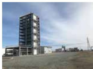
試験用プラント、市街地を再現したフィールドも設定
