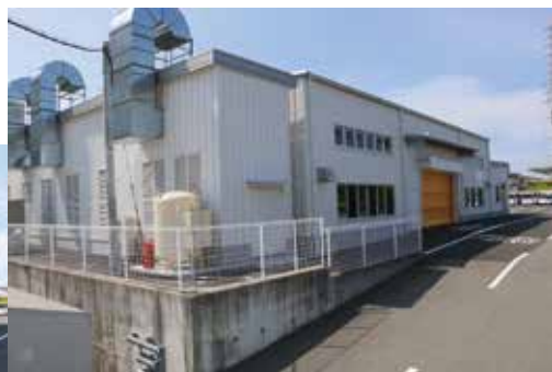
給排気装置を別棟の機械室に配置し、工場面積を500平米以内としている
