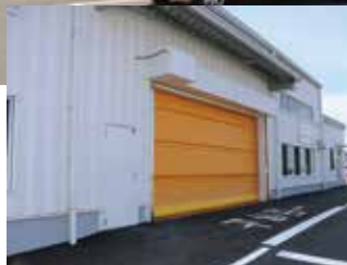
前面入口にスピードシャッターを設備
