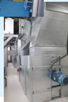
給排気装置を配置した機械室の内部
