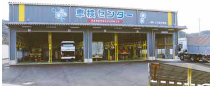
新工場の外観。 右端から検査ライン、大型ストール3、中型ストール1のレイアウト。
