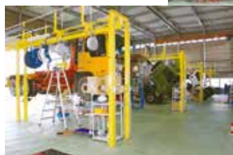
4ストール間を移動できる天井クレーンを設備。 ストール間の架台に各種リールを設備。
