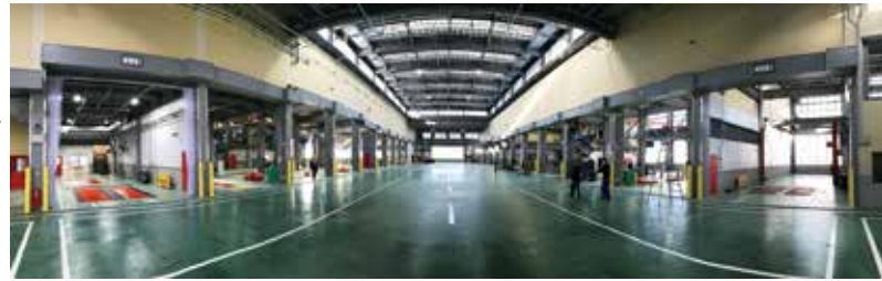
中央に広い通路を設け、天井高を高くした「ドーム型」建屋を採用。暖房設備により冬季にも快適な環境を実現。
