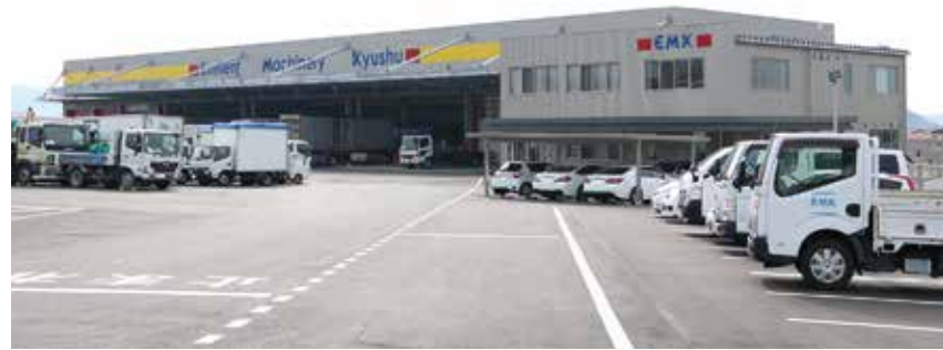
パラペットにシンボルカラーを配した工場の外観
