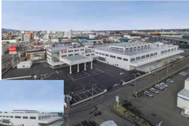
建物は延床面積約1万㎡、本社と札幌支店を併設。
