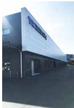
入出庫口には断熱性の高いシャッターを採用、省エネ・快適性に配慮。
