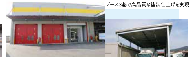
ブース3基で高品質な塗装仕上げを実現
