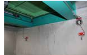
ワイヤー式と光電式、つま先の挟み込み防止の3重の安全装置を増備
