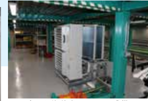
ピット内にも移動式クーラーを設備
