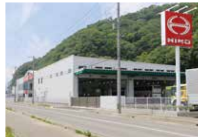
車検・一般整備棟から写真奥の洗車棟、板金塗装棟までを効率的に配置
