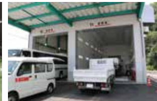
板金ストールと建屋一体型の塗装ブース
