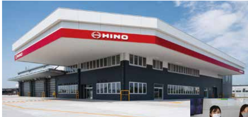
巨大なキャノピーを構える車検・一般整備棟、構内は右回りの一方通行に
