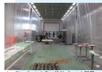
カーテンブースの奥に塗装ブースを配置。
