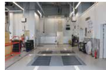
検査ラインにはトリプルテスターと固定式フリーローラー他を設備。
