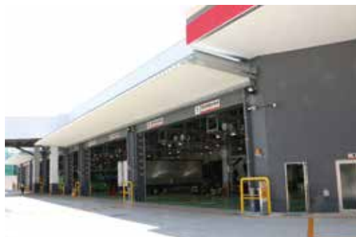
工場北側の一般・車検整備ストール。
