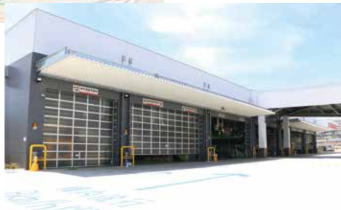
工場北側の12ストール。写真左側が車検整備、検査ラインを挟んで右側が一般整備ストール。
