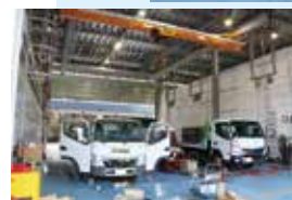
天井走行クレーンを設置した電装・車体整備ストール。
