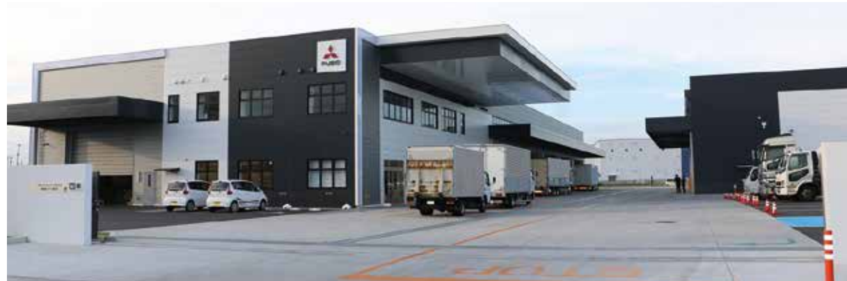
外観、左A棟、右B棟
