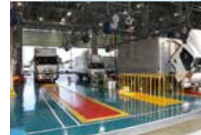
一般整備2ストールにはフロアリフトを設置。
