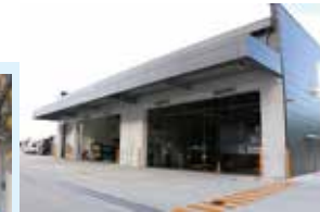
検査ライン2ストール、板金塗装場を併設したB棟。
