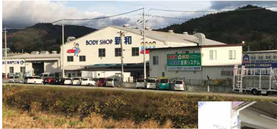
広大な敷地に2棟の車体整備工場、指定整備工場を有する。
