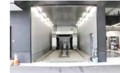
門型洗車機には自動下部洗浄機を併設し、洗車作業の負担を軽減。
