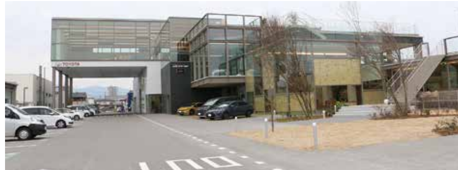
敷地面積5327平方メートル。愛媛みかんの「段々畑」のように、奥へ向かって高まっていくデザイン。
