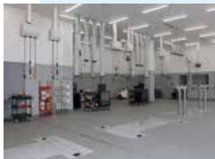
ストール右奥に分解整備場を広く取り、大型バッテリーのサービスにも配慮。
