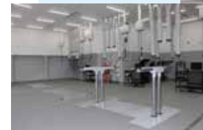
フラットな床面で安全、快適な作業環境を実現。
