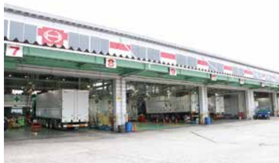
今回フロアリフトが導入された大型車整備工場。
