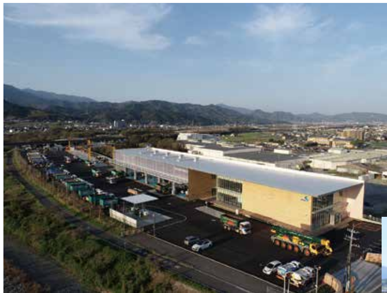
本社・サービス工場の全景。敷地奥側に橋形クレーン2基、洗車場を設置。
