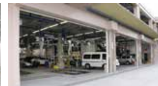
工場北側にはアライメント、クイック、重整備ストールを配置。
