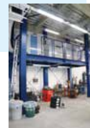
ドレンキャビネット、コンプレッサー等の配置も立体化でコンパクトに。
