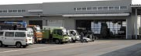
小型車整備、車体整備部門はB棟に
