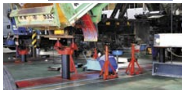
ツインエースの両側にグレーチングの側溝を設け、ピット内に排水できる
