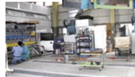
下地作業に床面吸塵装置を設備 (5号館車体整備実習室)
