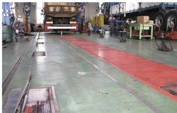
ストールの両側に吸塵装置のダンパーを設備
