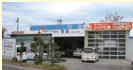
創業時からの钣金塗装工場、外観もきめ細かくメンテナンス
