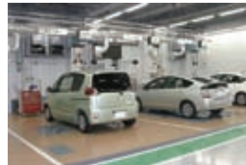
クイック、一般整備には作業性、安全性に優れたタンデムリフトを導入
