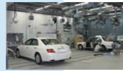
パテ付け、下地工程、ブースまでスライドレールで直結
