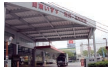
大型キャノピーを備えた工場入口
