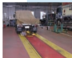
ピット幅が2段階になっており、各種車両に対応
