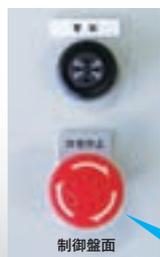
非常時に、この押しボタンスイッチを押すと全回路が遮断され、作動が停止します。制御盤の扉とリモコンスイッチに付いています。
