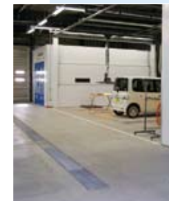
2基の塗装ブース、BPラインシステムで作業の流れがスムーズに
