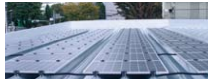
年間約2万kWhの発電が可能な太陽光発電パネルで環境貢献
