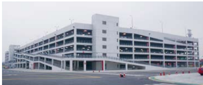
隣接する立体駐車場、2棟で6,000台を収容
